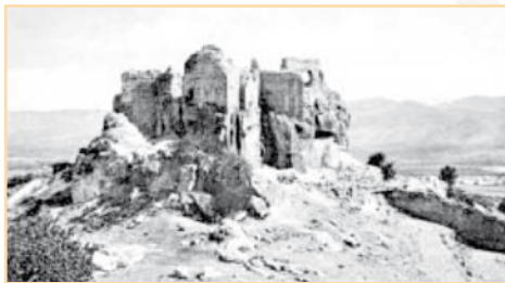
Fotografies de la silueta del castell, que mostren l'estat actual i el de 1926.
