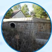
**12. Antiguo depósito de agua:** Inaugurado en 1966, a la vez que la red de alcantarillado local. Esta construcción significó una revolución en el agua potable para la época, pero sólo fue usado hasta el año 1971, ya que no tenía el suficiente desnivel para abastecer con presión las partes más altas del pueblo.
