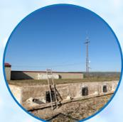
**8. Depósito de la Pedriza:** Desde 1975 este es el lugar en donde se almacena y trata el agua, suministrada a la población a través del sistema de tuberías. El agua que recibe el depósito llega hasta él directamente desde el minado, por una tubería soterrada para evitar la posible contaminación.
