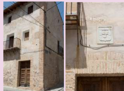
La Casa del Señor Feudal está siendo rehabilitada en los últimos años. A la derecha vemos el escudo nobiliario de los Sánchez Zapata de Calatayud.
