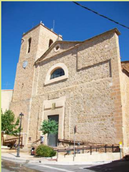
Fachada principal de la Iglesia de Ntra. Sra. de los Angeles. Foto: YMS
